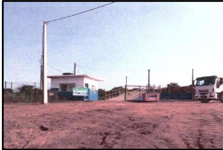
Figura 8 - Local do Ecoporto da Rodovia do Peixe, Rondonópolis, MT
