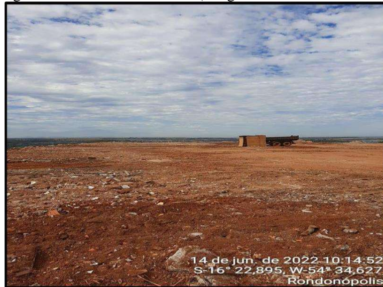
Figura 30 - Aterro Controlado (antigo lixão da Mata Grande)
