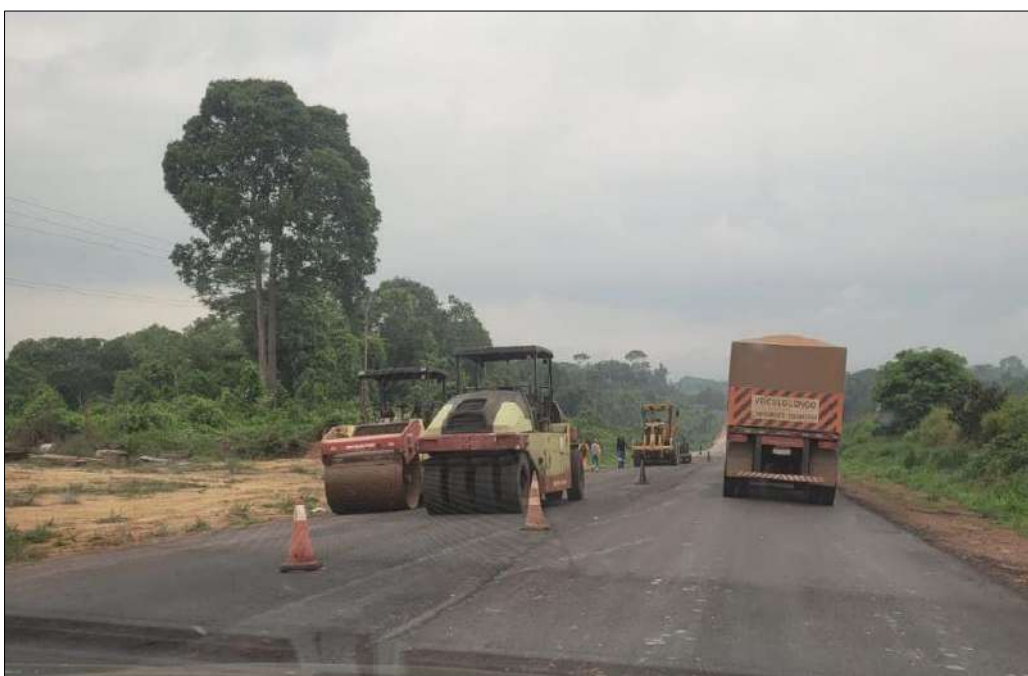
Imagem 36- Máquinas trabalhando enquanto o fluxo de veículos está parado
