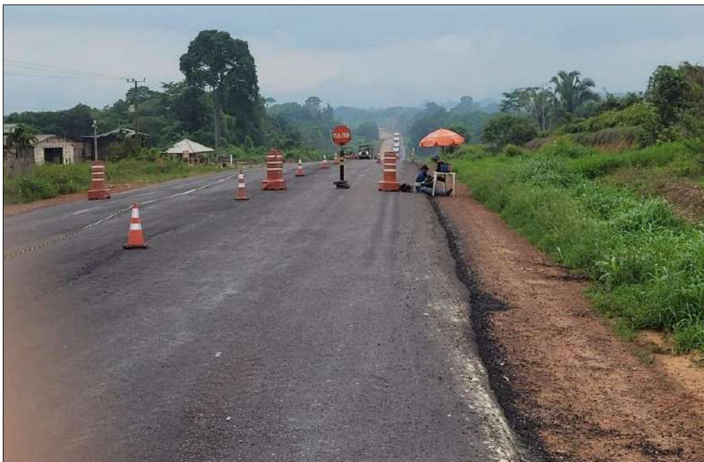
Imagem 35- Pavimentação da- via entre o KM 540 e 542
