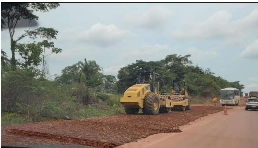
Imagem 28- Refazendo o asfalto
