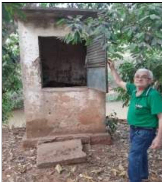
Figura 5.1.9 - Foto da Caixa de comando da bomba de captação de água do rio Areia que era aduzida para tratamento pela ETA da cidade de Juscimeira na década de 1970 com o Sr. Onofre Marcos ao lado.
