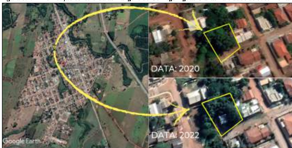
Figura 5.4.4 - Edificação construída às margens do Córrego Águas Claras na cidade de Juscimeira.
