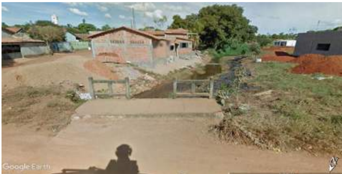
Figura 5.4.2 – Edificações sendo construídas dentro de uma APP, em 2015.
