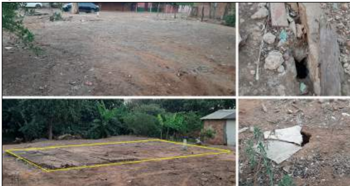
Figura 5.4.7 - Estrutura externa da fossa coletiva na cidade de Juscimeira-MT.
