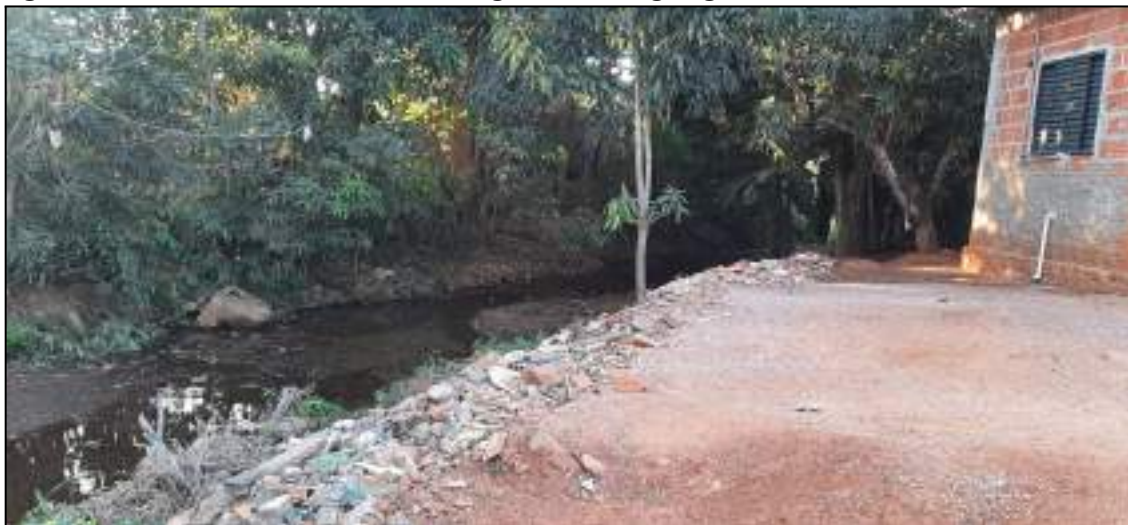
Figura 5.4.5 - Edificação construída às margens do Córrego Águas Claras na cidade de Juscimeira.
