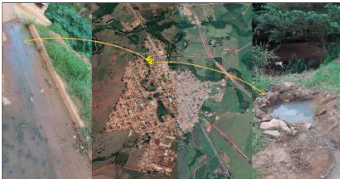
Figura 5.4.1 – Descarte de Esgoto Feito de Forma Irregular no Córrego Águas Claras Causando Problemas Socioambientais na cidade de Juscimeira.
