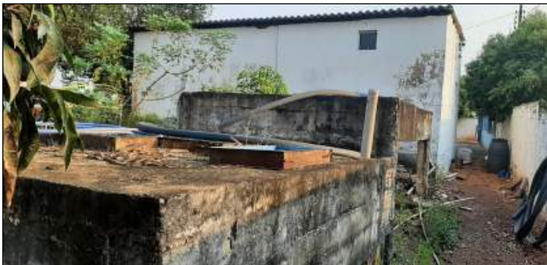
Figura 5.1.8 –Estação de Tratamento de Água (ETA) da cidade de Juscimeira criada na década de 1980.
