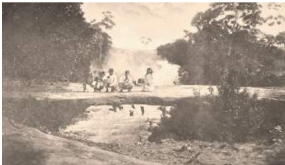
Figura 23: Ponte de Pedra
