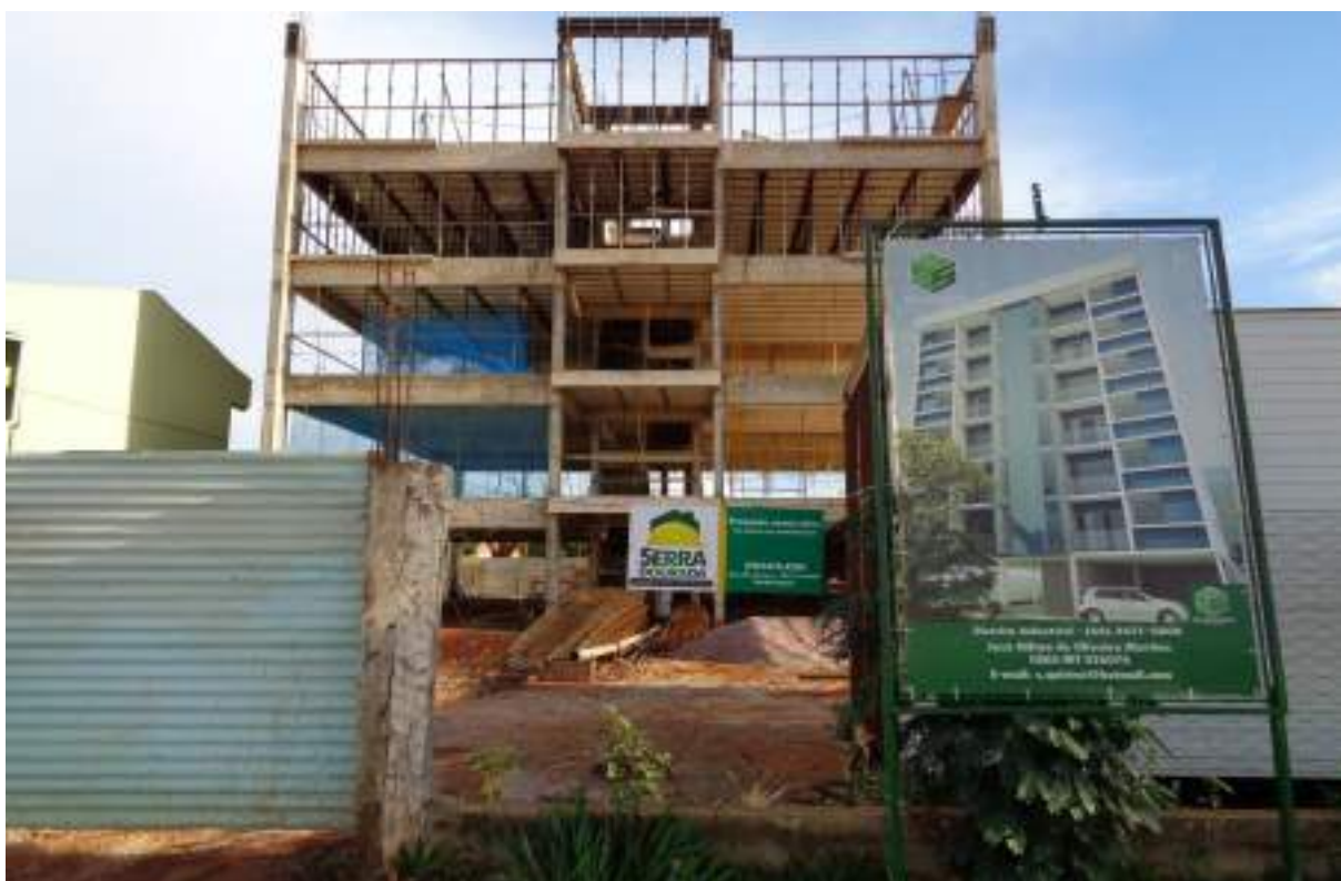
Foto- 27: Prédio em construção. MOREIRA. R.M. Jan/2017
