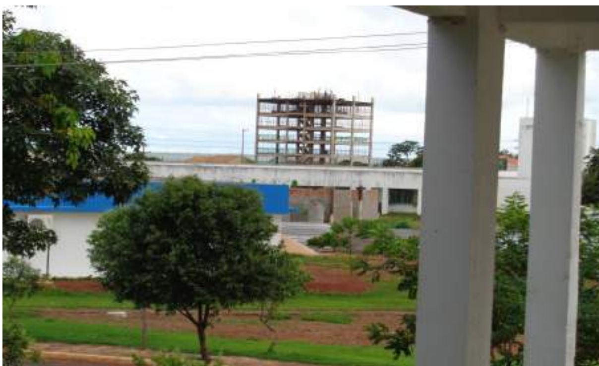
Foto 28: prédio em construção, em foto tirada do Campus Universitário, mais precisamente. MOREIRA. R.M. Jan/2017
