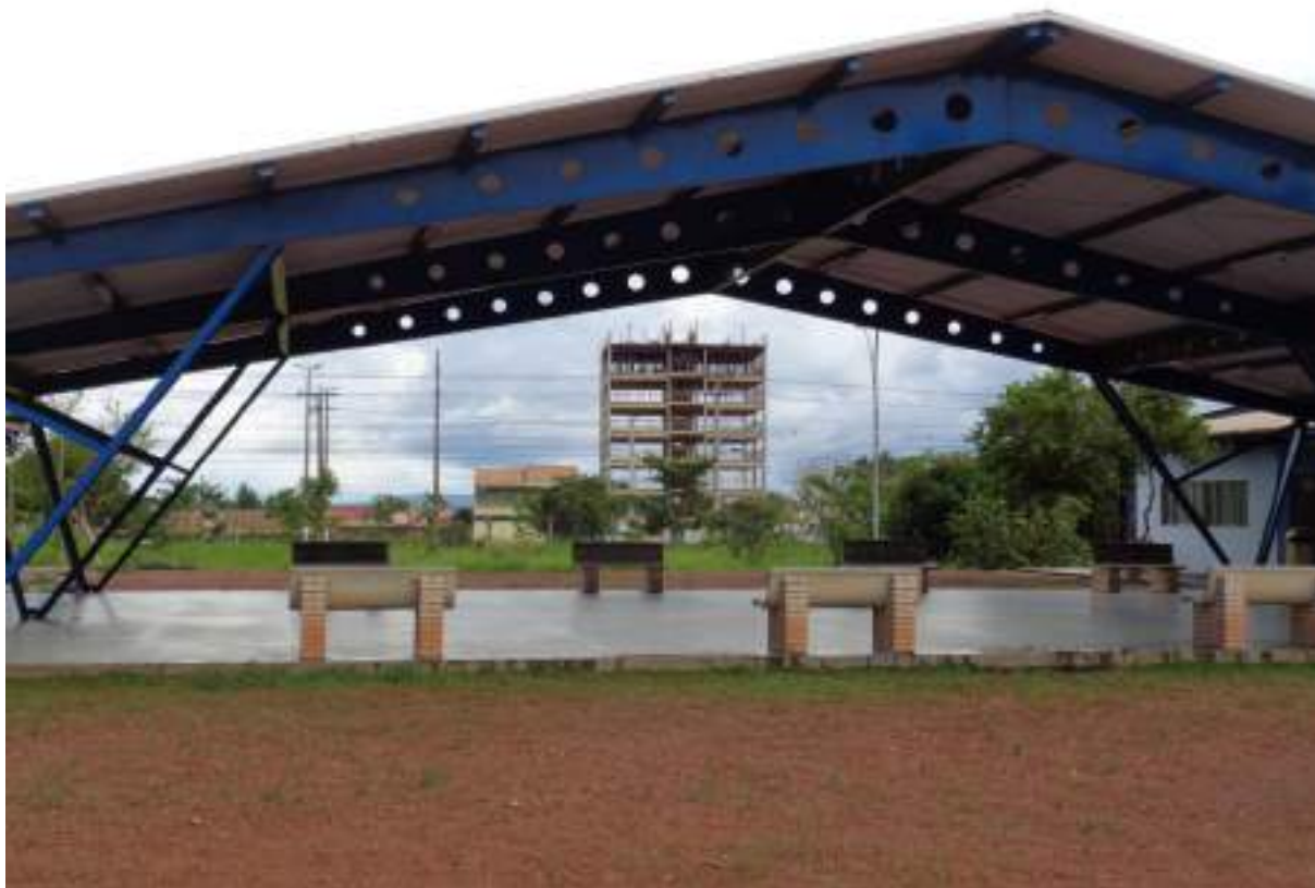
Foto29: Prédio em construção no Jardim Atlântico a partir do bloco da Psicologia. MOREIRA. R.M. Jan/2017
