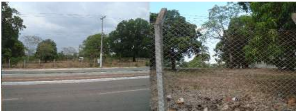
Figura 17: Empreendimentos abandonados subutilizando o espaço urbano.
