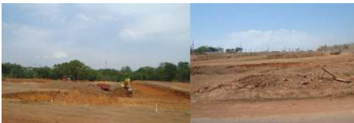
Figura 23: Processo de terraplanagem para urbanização da área.
