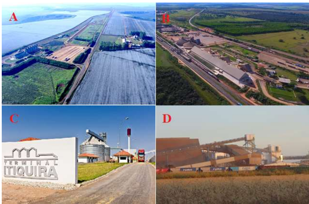
Figura 7 – A) Terminal Ferroviário em Alto Taquari; B) Terminal Ferroviário em Alto Araguaia; C) Terminal Ferroviário em Itiquira; D) Terminal Ferroviário em Rondonópolis
