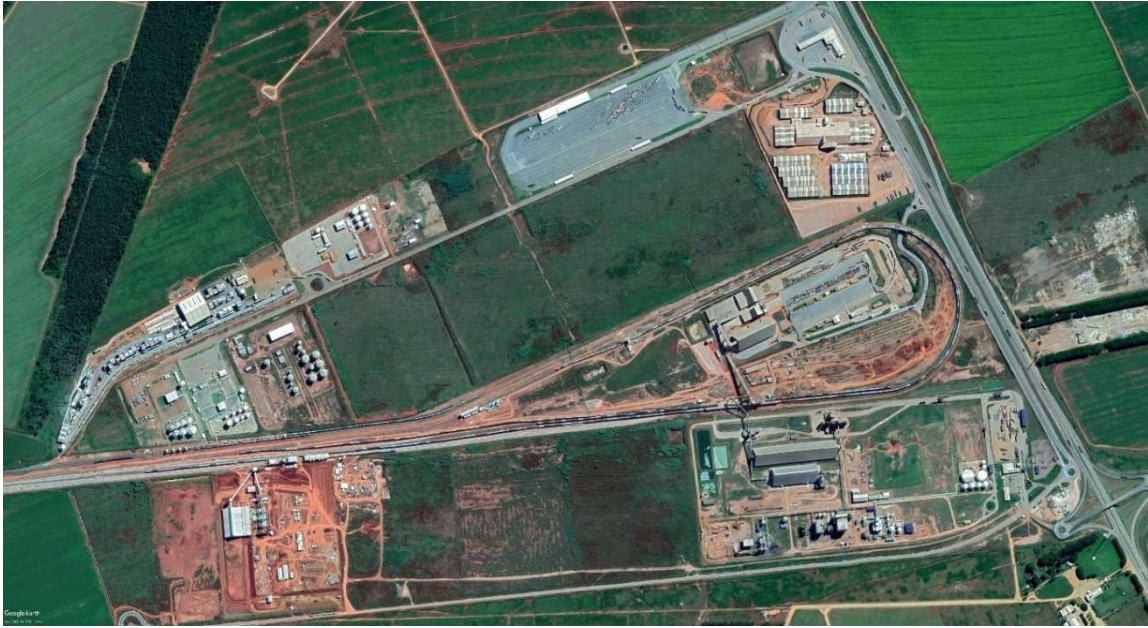
Figura 10 – Terminal Intermodal de Rondonópolis (2018)
