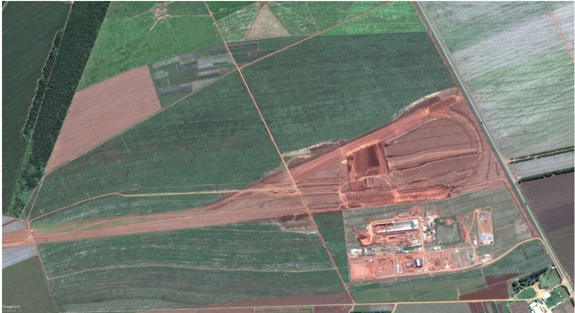
Figura 8 – Início das obras do terminal de Rondonópolis (2012)
