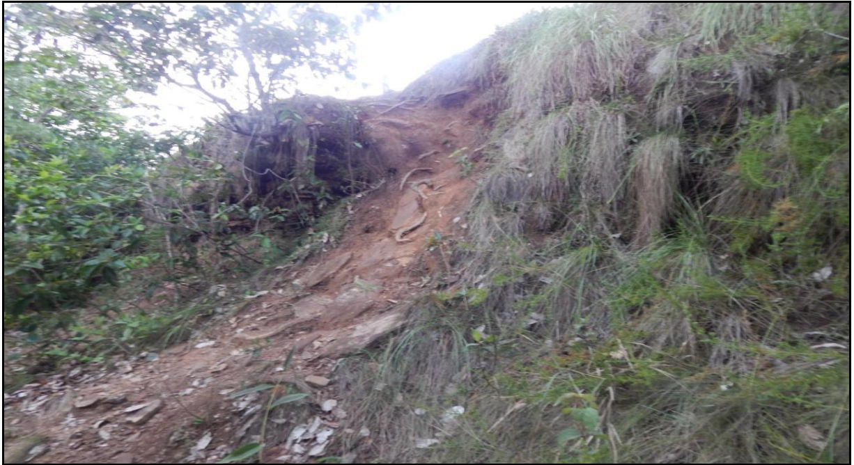
Foto 1 - Trecho degradado em processo de erosão em uma das trilhas abertas para dar acesso às cachoeiras do Assentamento Carimã
