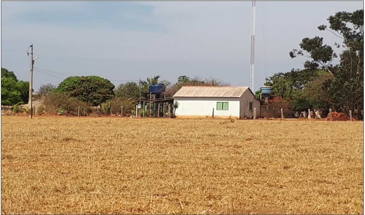
Foto 1 – Infraestrutura de uma residência no P.A. São José Operário Org.: OGAWA, E.A. Dados levantados em trabalho de campo, 08/2019.
