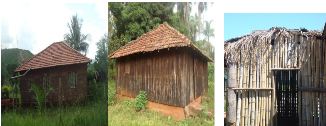
Figura 19: Construção tipo alvenaria. Figura 20: Construção tipo mista. Figura 21: Construção tipo tradicional. Fonte: BALDO, A.C.S. 2015.
