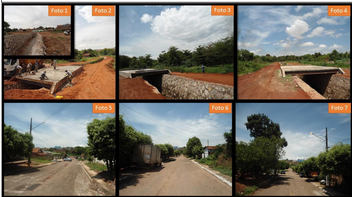
Figura 14: Pontes construídas após a canalização
