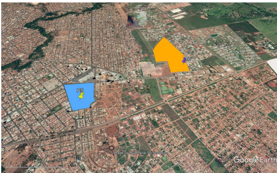
Figura 23: Localização no Contexto da Malha Urbana da Cidade de Rondonópolis das Edificações Habitacionais (P5 e P6) com Padrões de Construção Médio e Alto Respectivamente. Fonte: Google Earth (acesso em fev. 2020).
