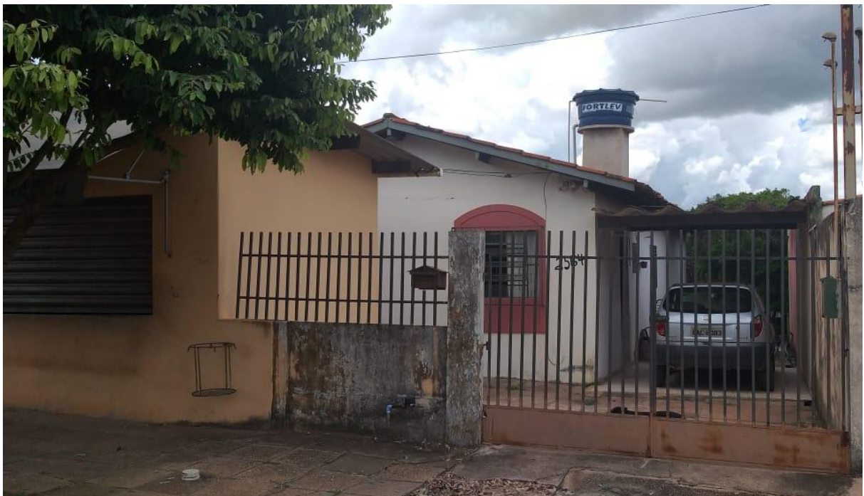
Figura 22: Aspectos Externos da Construção da Habitação P4 localizada no Conjunto Habitacional Jardim Belo Horizonte no setor oeste da cidade de Rondonópolis.
