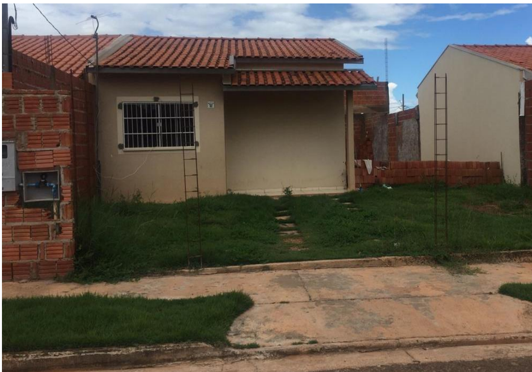
Figura 20: Aspectos Externos da Construção da Habitação P3 localizada no Conjunto Habitacional no Residencial Três Américas no setor leste da cidade de Rondonópolis. Fonte: Negri Filho, D. (2021).
