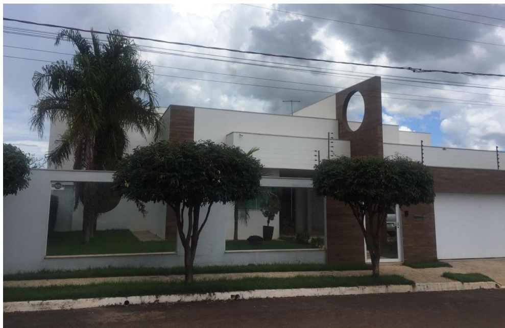
Figura 27: Aspectos Externos da Construção da Habitação P6 localizada no Bairro Jardim Sunflower no setor leste da cidade de Rondonópolis.
