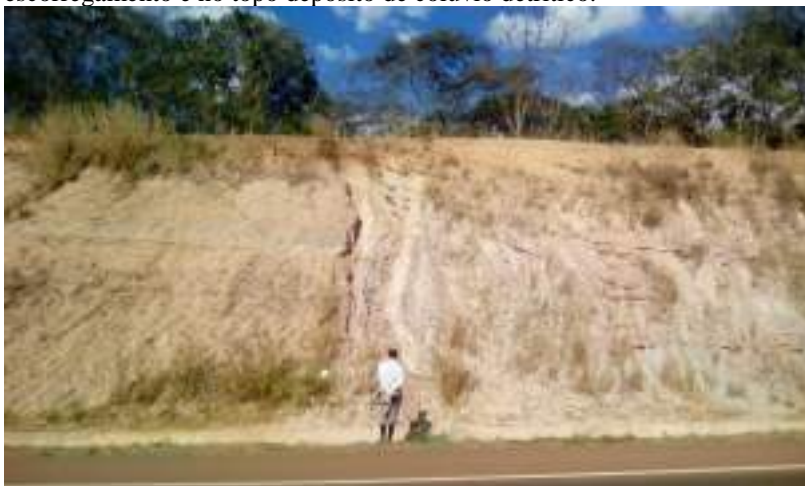
Figura 4.13 – Fotografia de afloramento exposto falha normal de pequeno rejeito, onde a esquerda ocorre arenito pertencente a Formação Furnas, a direita siltito e arenito intercalados da Formação Ponta Grossa, no centro escorregamento e no topo depósito de colúvio detrítico.
