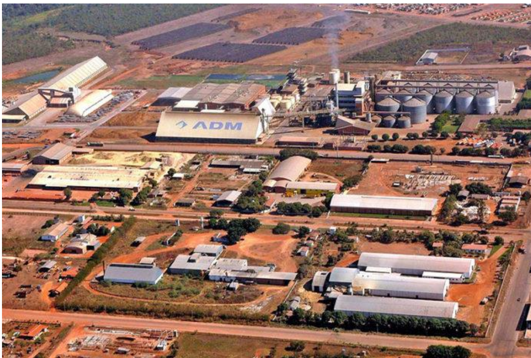
Figura 8 – Vista oblíqua do terreno da Empresa ADM na cidade de Rondonópolis-MT
