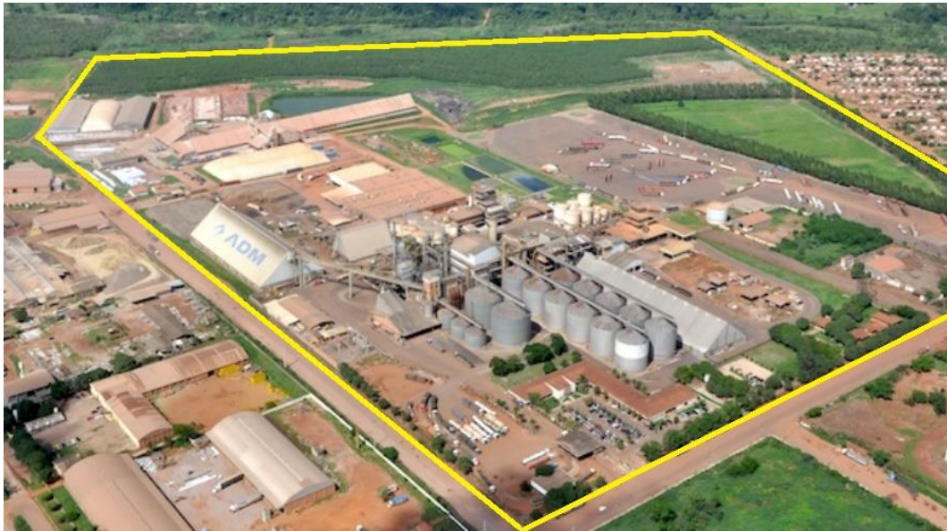
Figura 7 – Vista oblíqua do terreno da Empresa ADM na cidade de Rondonópolis-MT
