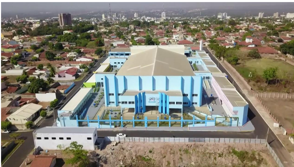
Figura 12: vista oblíqua da fachada principal (ala sul) do Centro De Evangelismo “Pastor Cícero Canuto de Lima” conhecido também como “Grande Templo”
