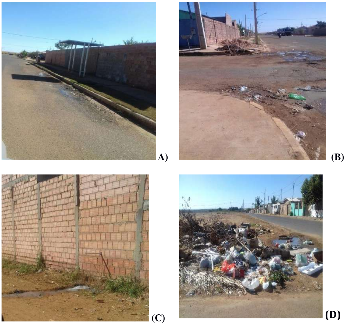
Figura 4.26: Locais com acúmulo de lixo e água parada, loteamento Primavera III, Primavera do Leste, Mato Grosso.
