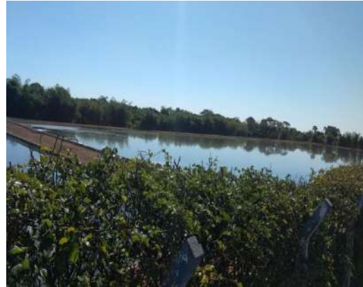
(F) Sistema de tratamento de água/esgoto, próximo a APP – Riva.
