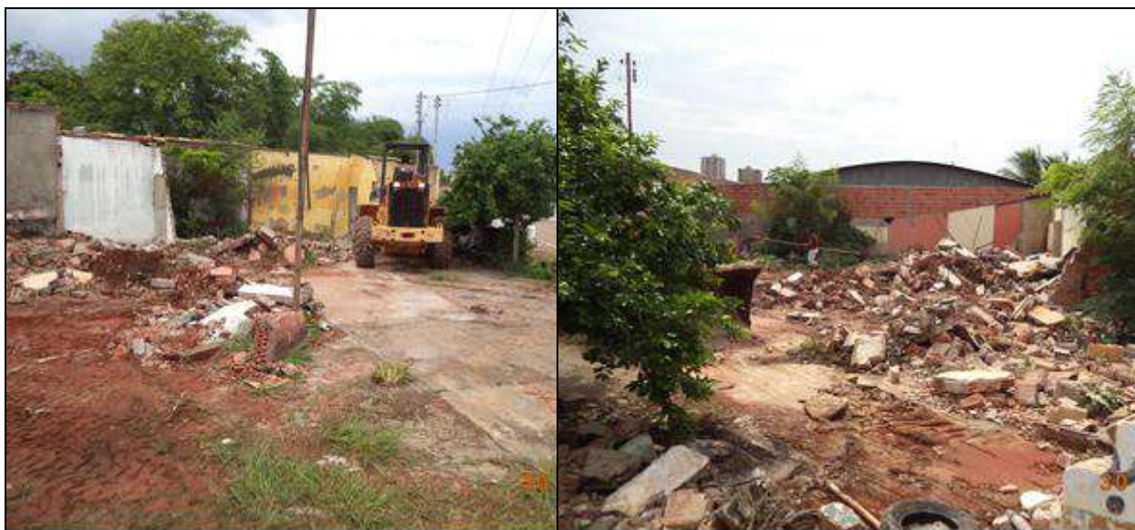
Figura 5.5 Demolição de edificações irregulares instaladas na APP do Ribeirão Arareau, na cabeceira da ponte da Rua José Barriga, Bairro Jardim Paulista.
