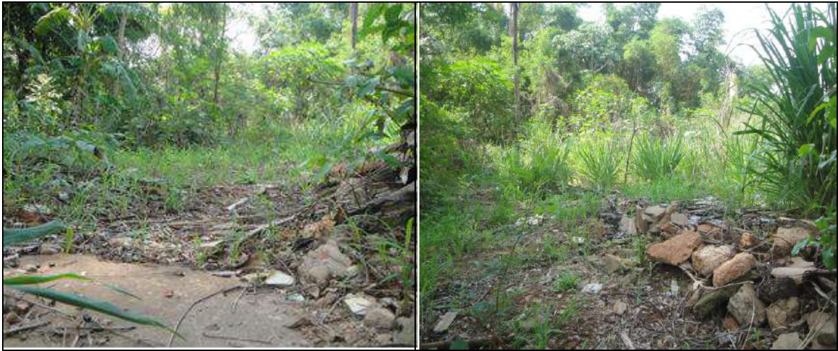
Figura 5.7. APP do Ribeirão Arareau na Av. General Falconiere, Bairro Vila Aurora, onde ocorreram demolições de edificações, restando ainda contra piso e resíduos sólidos de concreto.
