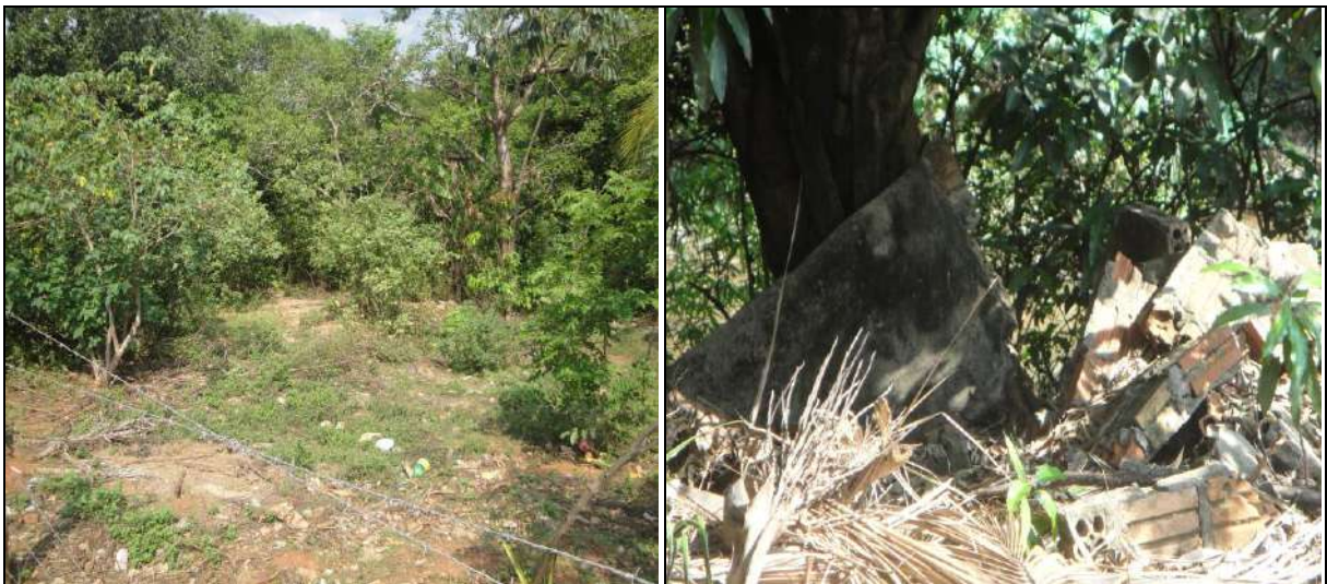
Figura 5.8 APP do Ribeirão Arareau na Rua H, Bairro Jardim Paulista, onde ocorreram demolições de edificações, restando ainda contra piso e resíduos sólidos de concreto.
