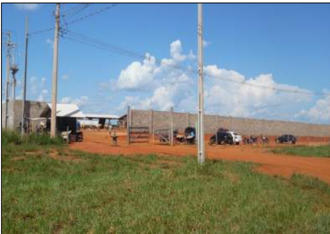
Foto 5.32- Loteamento Boulevard do Cerrado – vista do canteiro de obras do condomínio.
