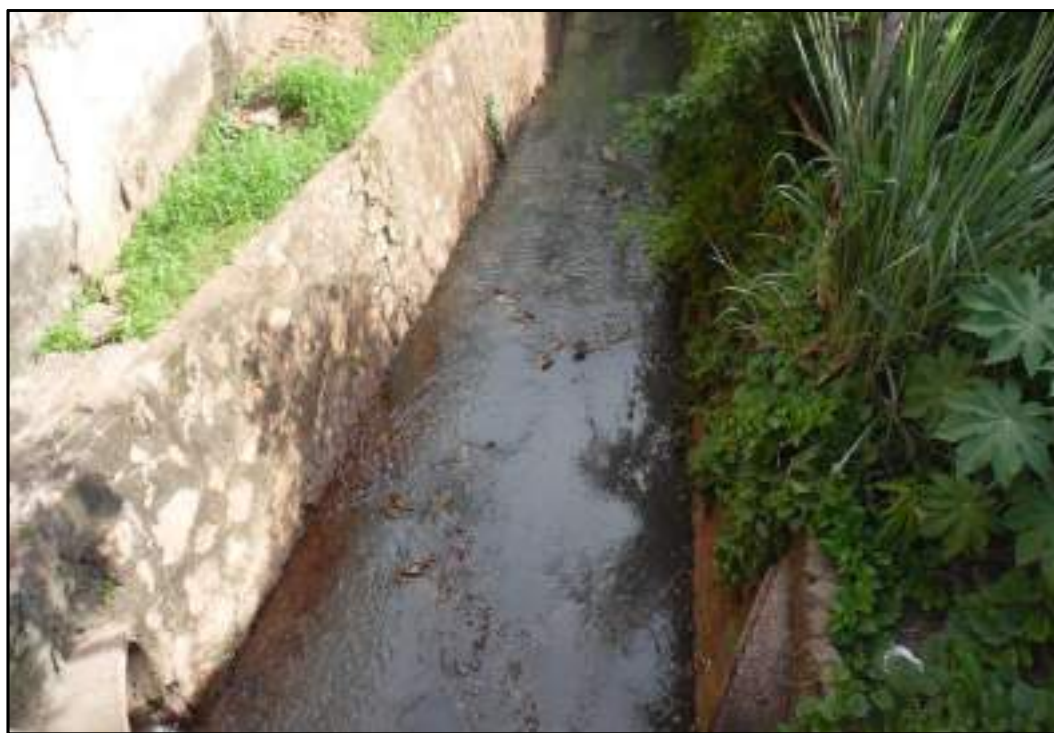
Foto 5.10- Córrego Patrimônio – Região Central – Observamos a canalização aberta, à aproximadamente 100 metros da nascente do curso d'água. Foto: A. A. P., Maio/2016
