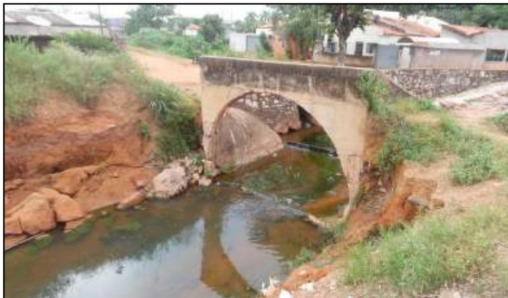
Foto 5.14- Córrego Bambu – esta área traz lembrança de um ambiente pós-guerra, especialmente após a destruição da ponte que aconteceu após um período de enchente, a mais ou menos um ano e meio atrás. Foto: A. A. P. Maio/2016
