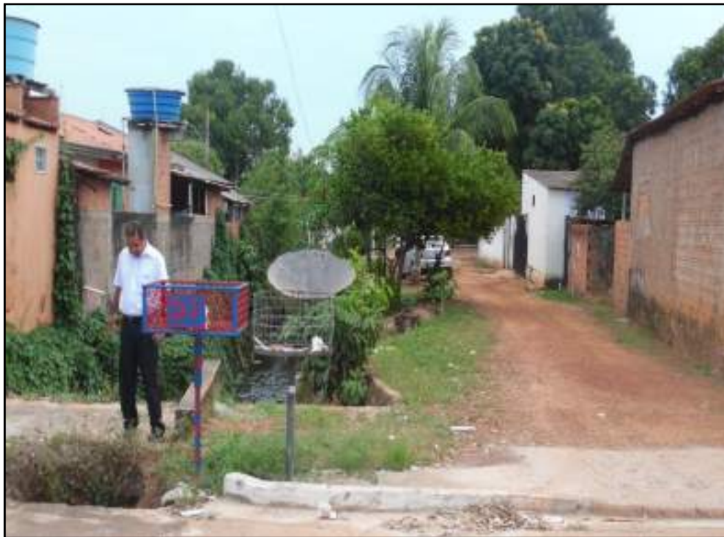
Fotos 5.12- Córrego Patrimônio – Loteamento Alves, Presença de construções desrespeitando a distância mínima de 10 metros da canalização, esgoto sendo jogado diretamente no Córrego através de encanamentos das moradias, lixo. Foto: A. A. P., Maio/2016
