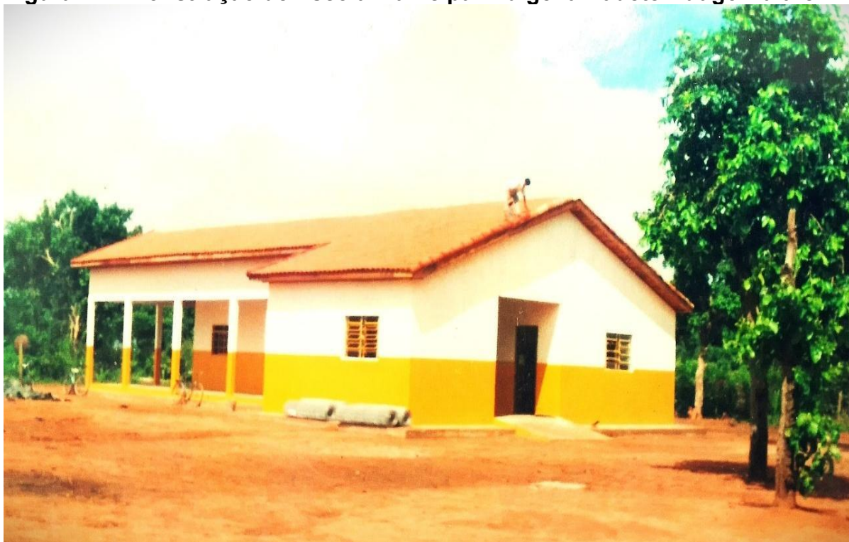
Figura 17 – Construção de Escola Municipal Indígena Cadete Adugo Kuiare
