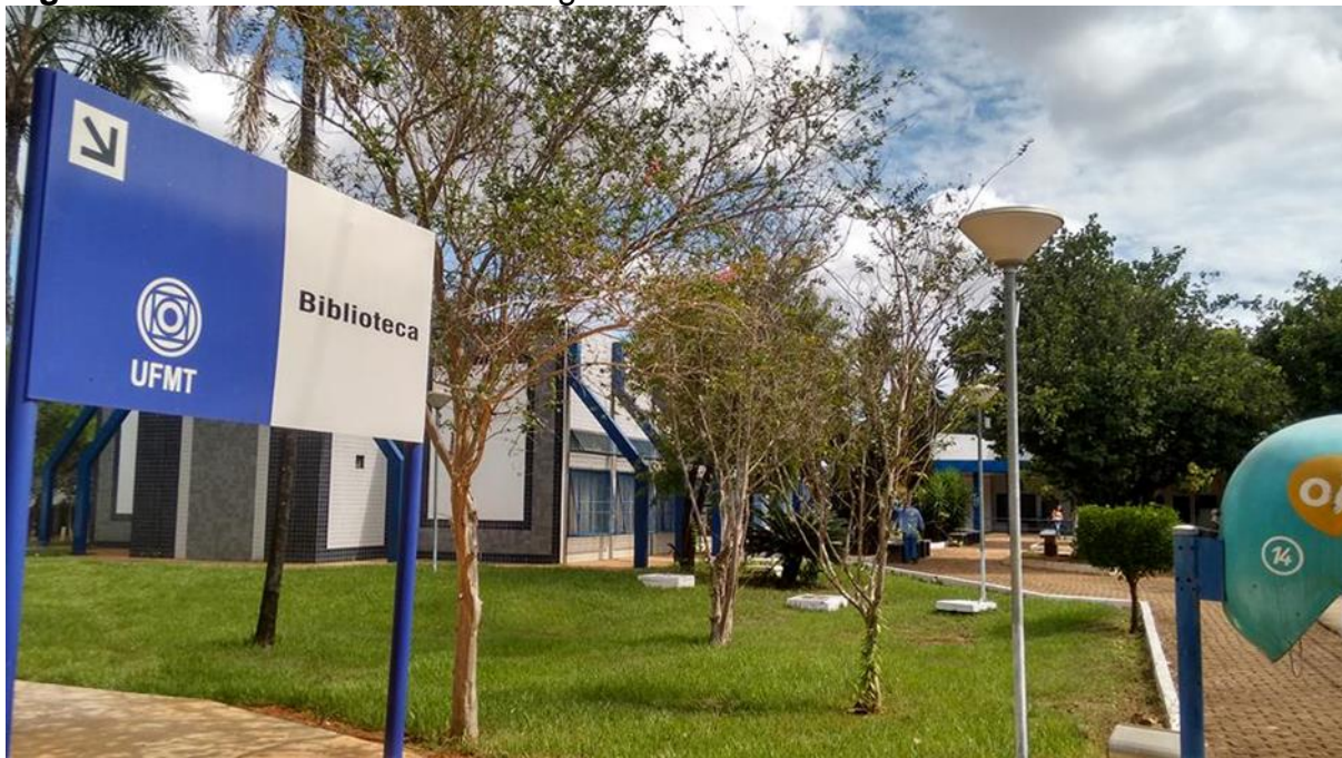
Figura 1 – Prédio da Biblioteca Regional da UFMT/CUR
