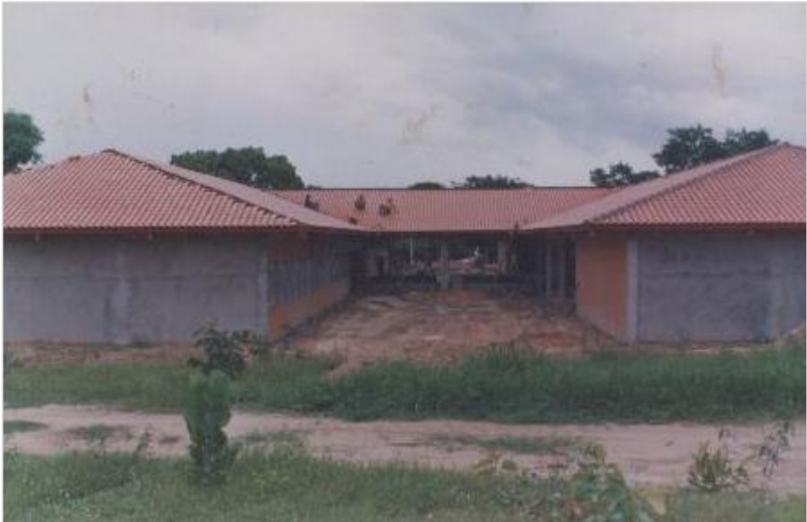
Figura 3 – Construção do CPCX da UFMS, 08/12/2006
