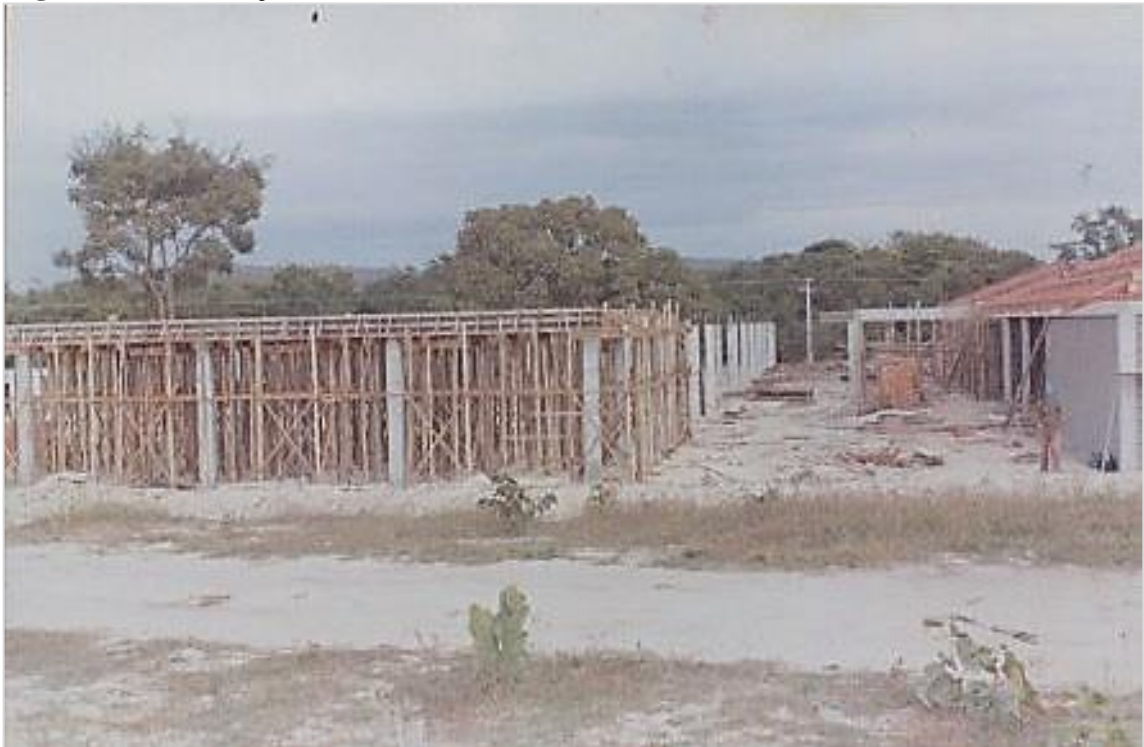
Figura 2 – Construção do CPCX da UFMS, 22/06/2006
