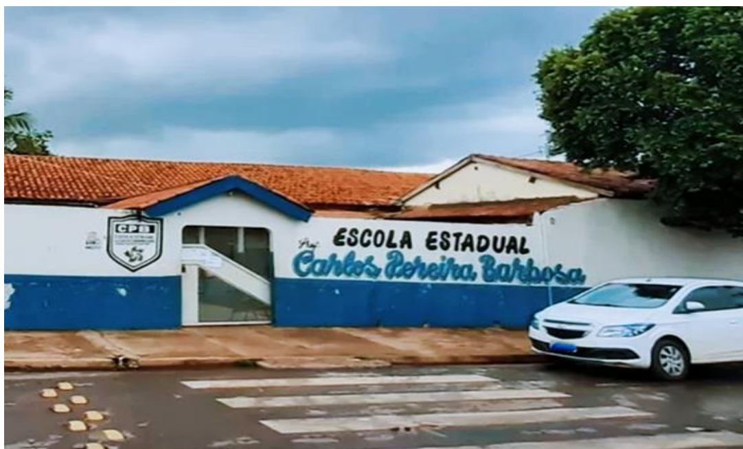
IMAGEM 3: Fachada da Escola lócus
