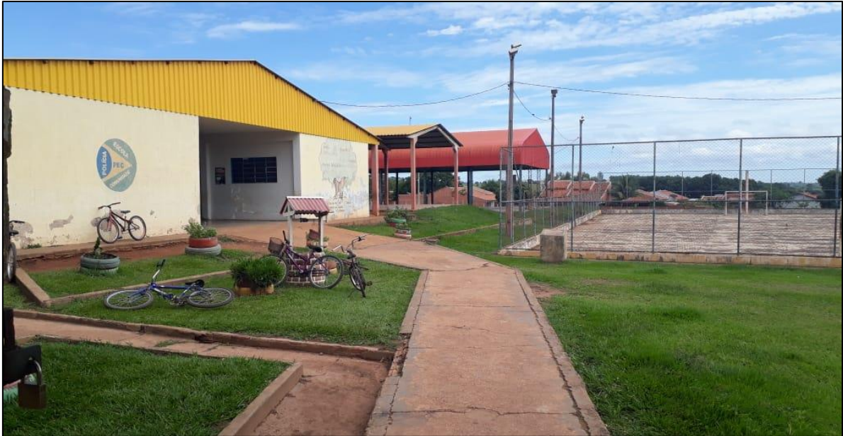
Figura 2 - Fachada da instituição
