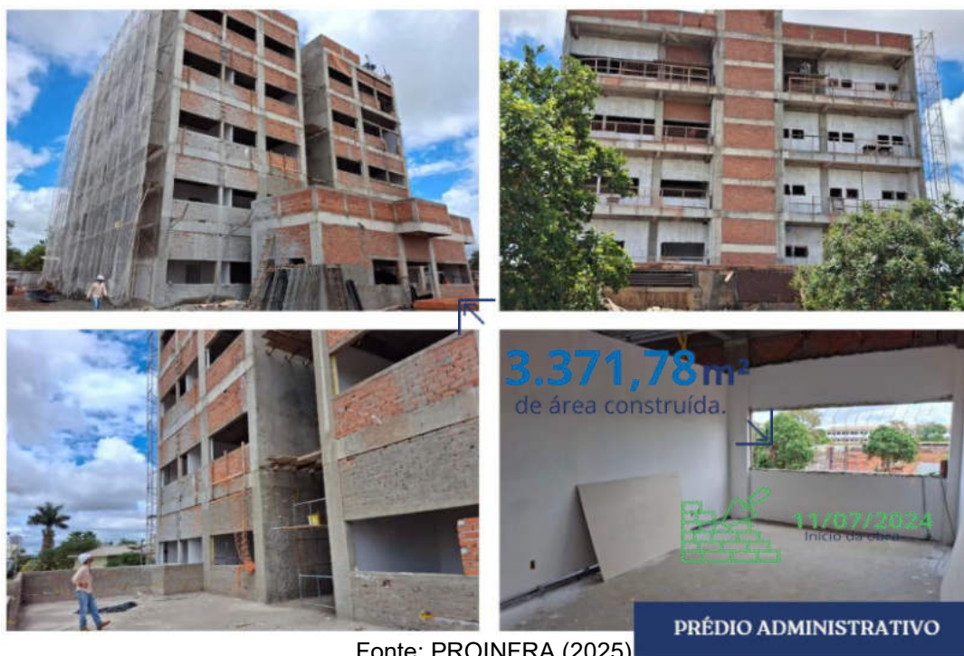
Figura 140: Situação da Obra do Prédio Administrativo em Novembro de 2025.
