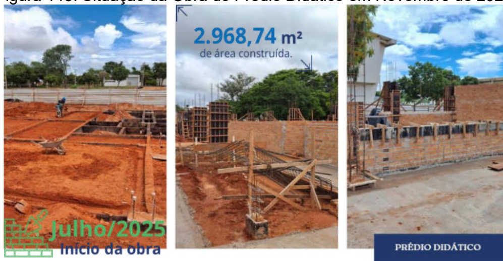
Figura 143: Situação da Obra do Prédio Didático em Novembro de 2025.
