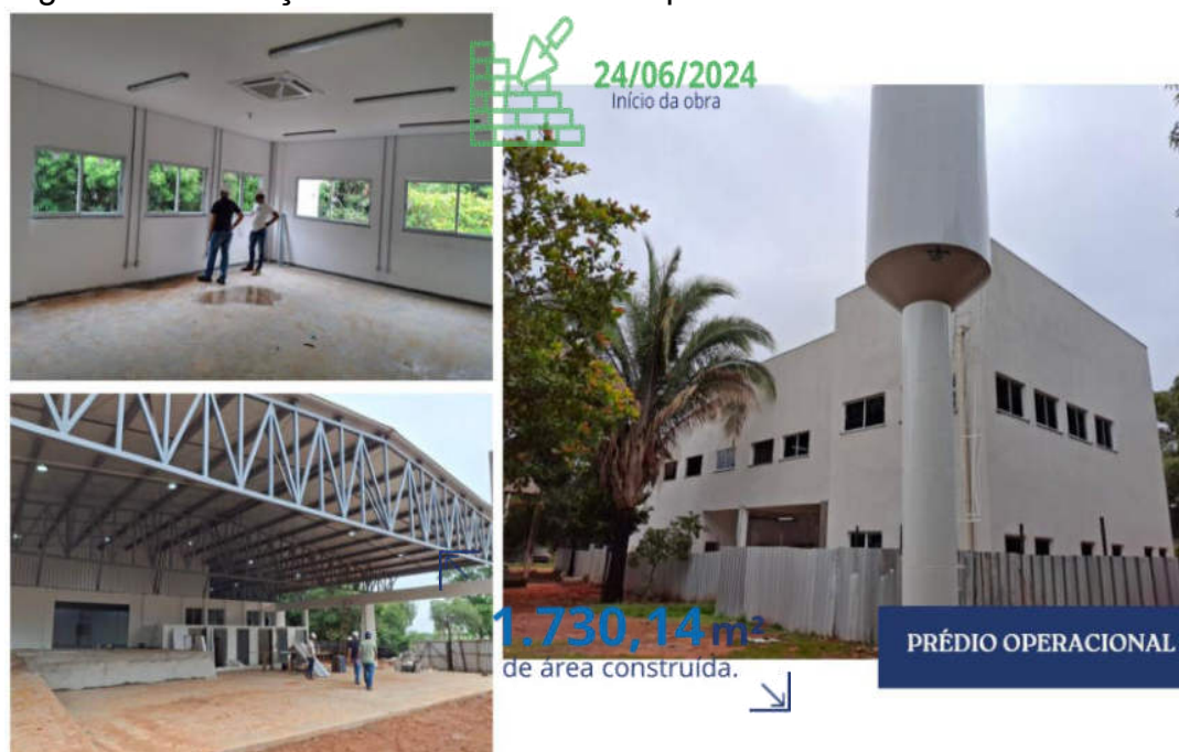
Figura 139: Situação da Abra do Prédio Operacional em Novembro de 2025.
