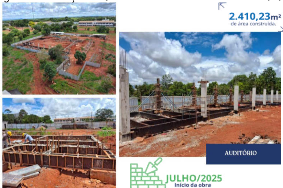
Figura 141: Situação da Obra do Auditório em Novembro de 2025.
