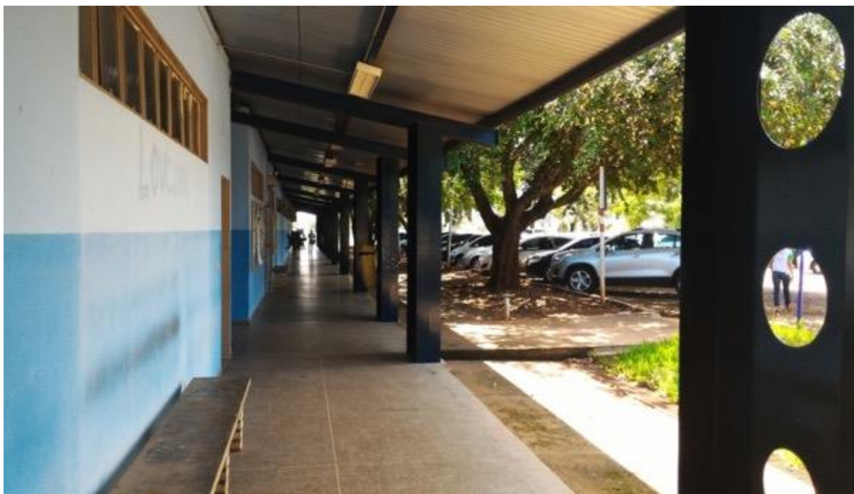
Figura 03: Foto do Bloco da Psicologia
